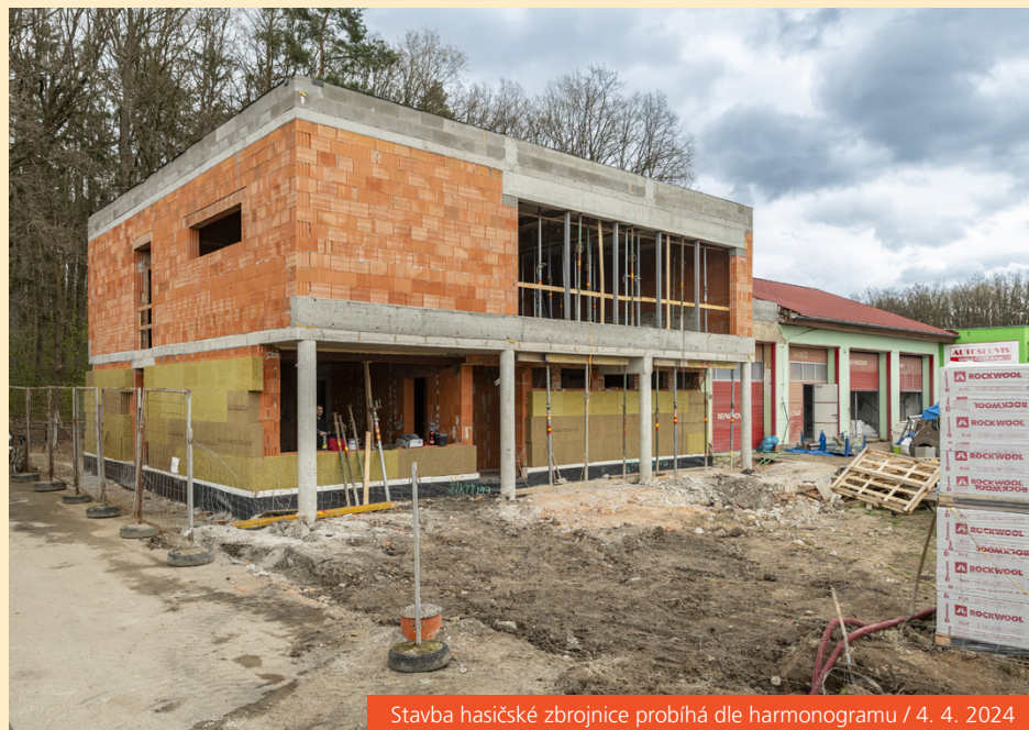
Stavba hasičské zbrojnice probíhá dle harmonogramu / 4. 4. 2024
